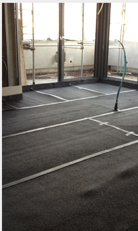
Particola delle fasi di posa del materassino DAMPROLL BOSCO VERTICALE (MILANO)
