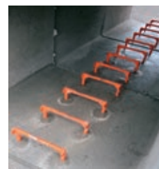
Particolare con gradini installati.
