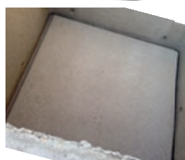
Vista del basamento dall'interno
