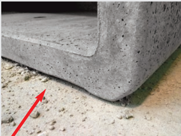
Particolare dei distanziali angolari a protezione perimetrale
