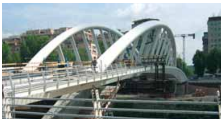
Ponte della Musica - Roma - Calcestruzzo leggero strutturale.
