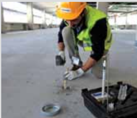
Prova in opera di umidità.
