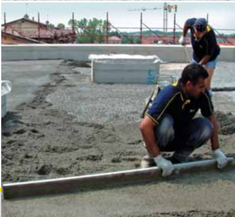
Strato di pendenza isolante per l'incollaggio diretto della membrana
