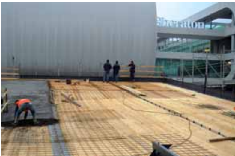
Aeroporto Malpensa (VA) - Massetti leggeri e isolanti.
