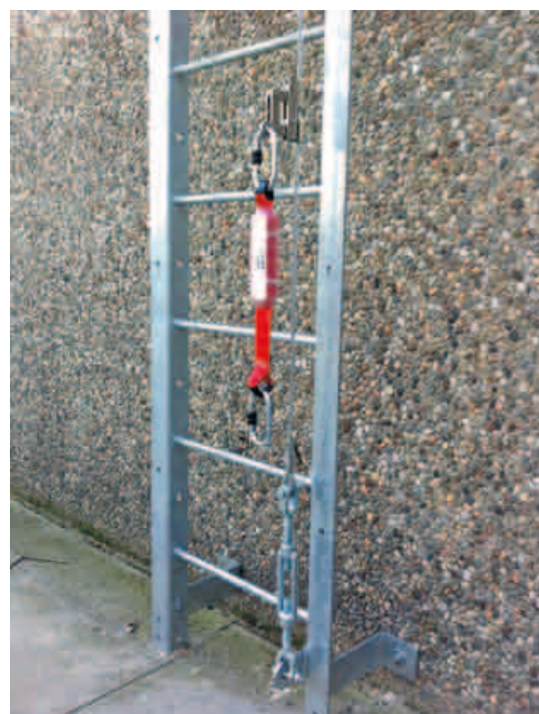
Particolare del kit di sicurezza con carrellino autobloccante Cable Fall Arrester 1317
